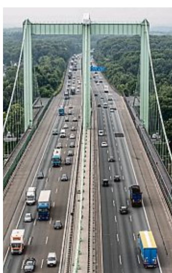
Die Rodenkirchener Brücke ist Teil des Ausbaubereichs. Foto: ths
